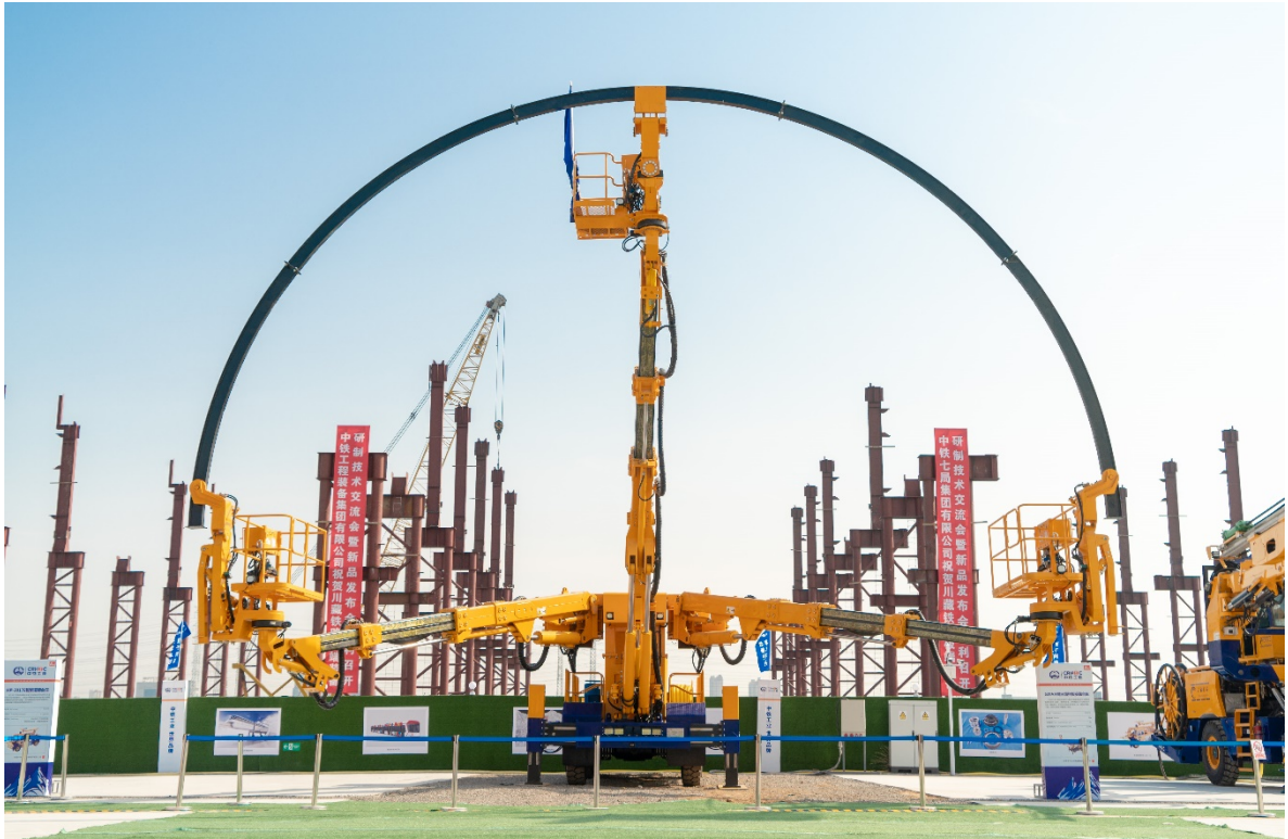
图 23: GJ3A 三臂三篮拱架安装台车是应用于隧道拱架安装的新型施工设备,集拱架安装、辅助网片安装、锚杆安装等多功能于一体,应用于川藏铁路,可大大减少人员作业强度,推进隧道施工机械化进程。
